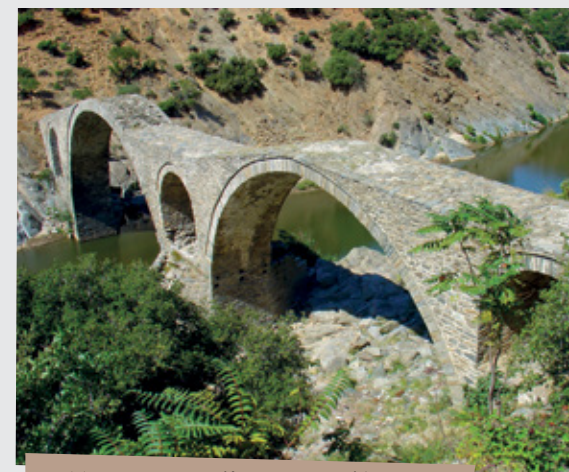
Мост на река Компсатос, Иасмос
