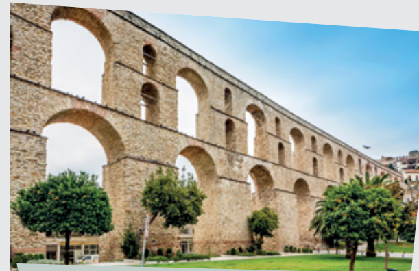
Impresionantele bolti ale vechiului apeduct
