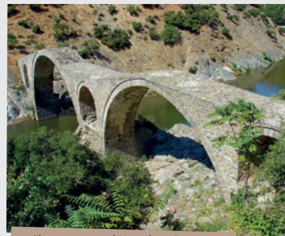
Γέφυρα ποταμού Κομπάτου, Ίασμος
