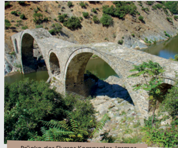
Brücke des Flusses Komsatos, Iasmos
